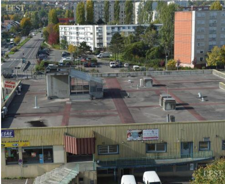
Vidé de ses occupants, le centre commercial Jeanne-d'Arc pourrait être détruit pour l'été 2025.
